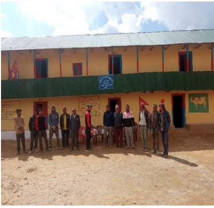
वडा नं ४ इन्द्र सेवक प्रा वि भवन मर्मत
