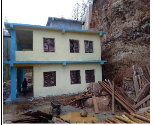
वडा नं २ गंगा मा वि चौतारा ४ कोठे भवन निर्माण
