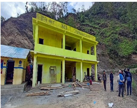
जनविकास प्रा वि नेटापरी २ कोठे भवन निर्माण तला थप वडा नं ६
