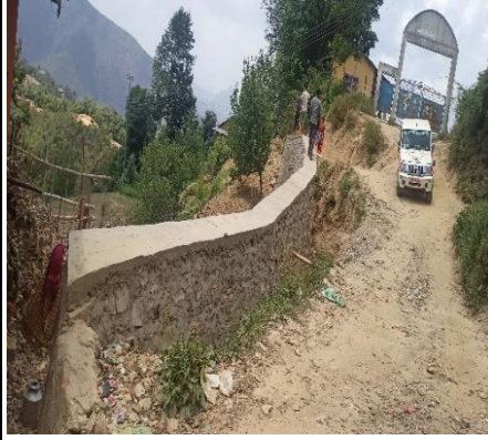
वडा नं ३ नाउली स्कुल अगाडी मेसिनरी वाल भवन निर्माण
