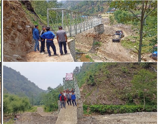
डलसिङ्ग खोला ट्रस पुल निर्माण वडा नं ४
